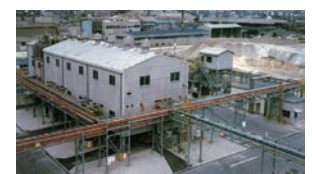
有機フッ化物の多目的製造設備 (1984年)
