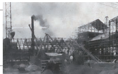
建設中の塩化リン安(高度化成肥料)工場
